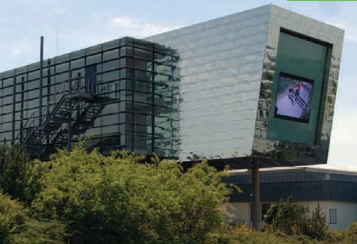
Schulungszentrum der Handwerkskammer Koblenz, eingedeckt mit TECTOFIN RV von WOLFIN Bautechnik.
